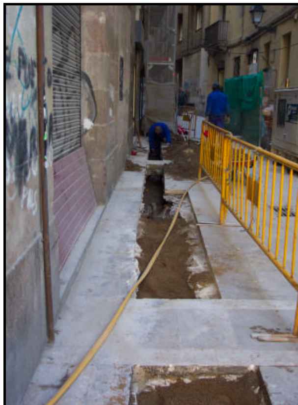
Foto 7: Vista general del tram 3
