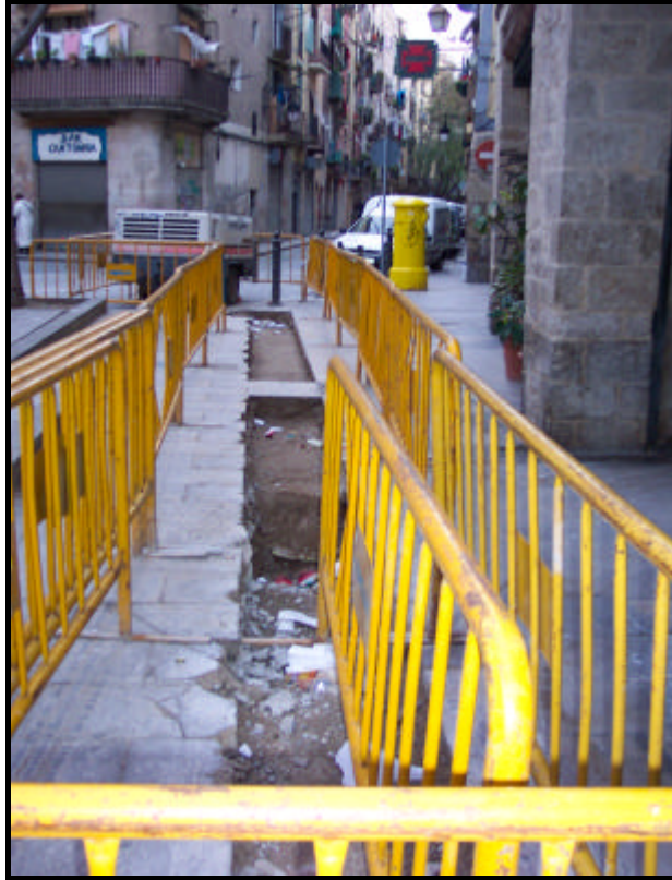
Foto 1: Vista general del tram 1
